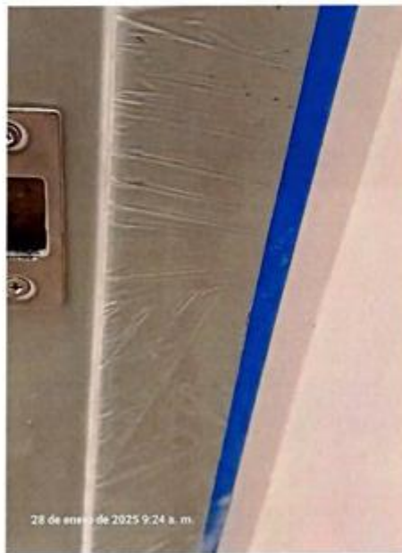
Detalle de marco de la puerta
